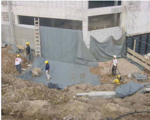
Foto N° 2 - Tendido de capas de geotextil para dren
