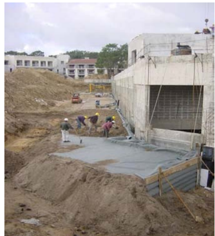
Foto N° 7 - Muro a media altura
