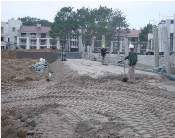
Foto N° 8 - Compactación de la última
