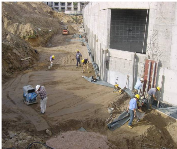
Foto N° 6 - Compactación del relleno
