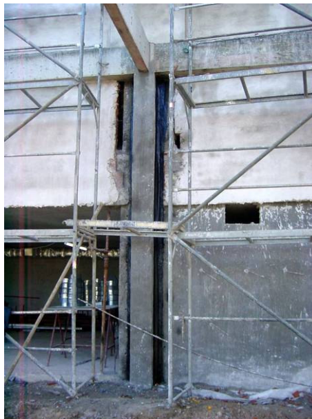
Foto N° 1 - Vista del muro de bloques al inicio de la obra
