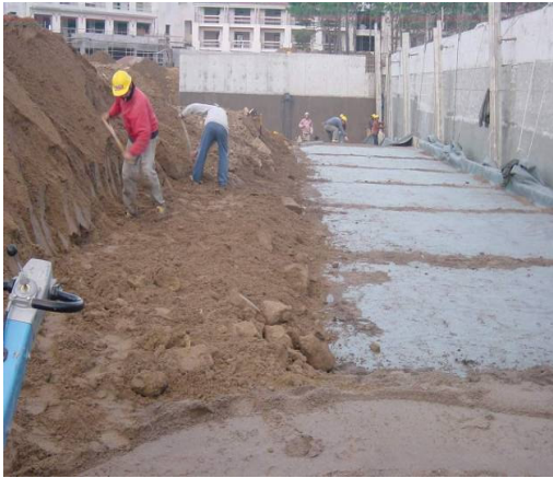
Fotos N° 4 y 5 - Tendido del material de relleno en forma manual y con pala cargadora
