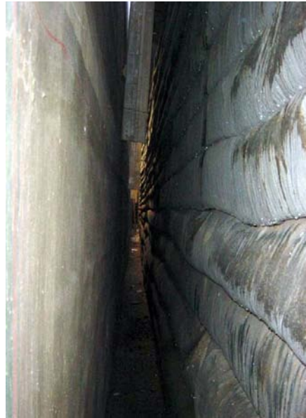
Foto N° 9 - Vista del muro terminado en el interior de la
