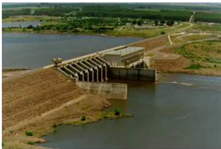
Figura 1.- Vista general de la presa
