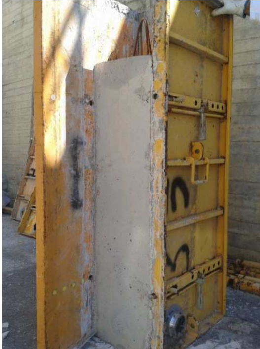
Figura IV.- Columna desencofrada a 4,88 MPa
