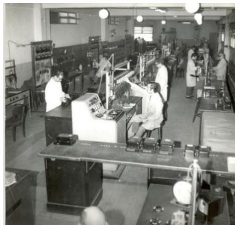
*Figura XX. Sala de calibración de medidores de energía del laboratorio de UTE.*
